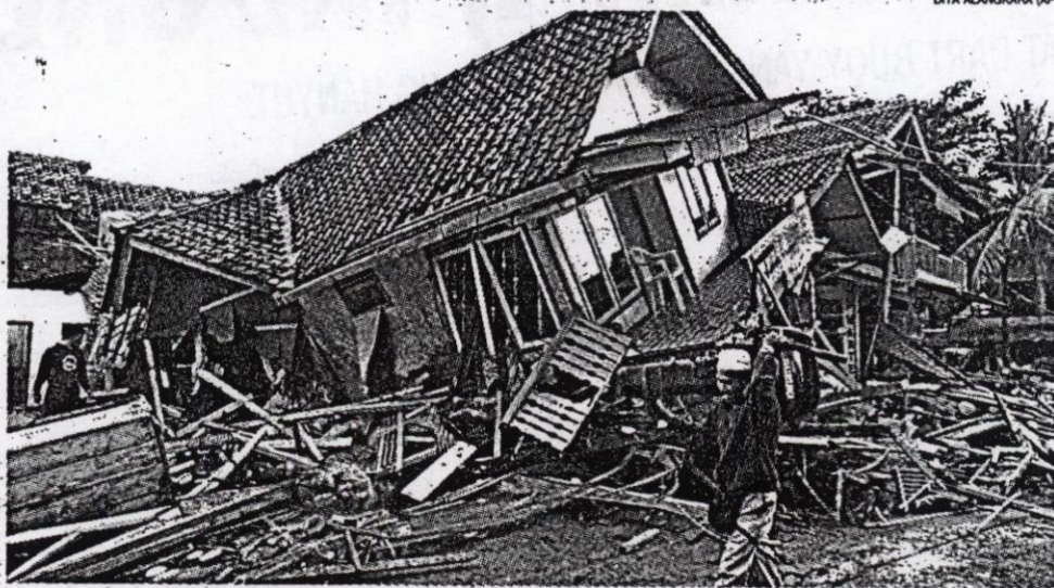
Reruntuhan rumah penduduk di Pangandaran, Jawa Barat, setelah tsunami.
