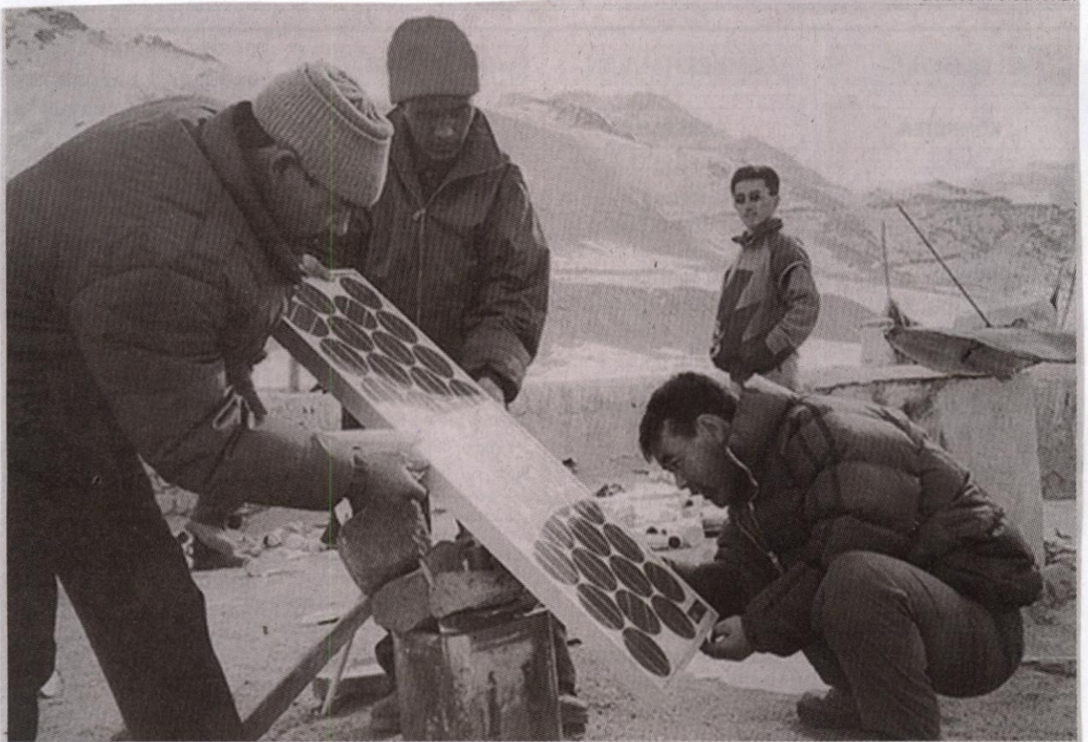
SEL SURYA: Dengan wafer Si, energi surya dapat diubah langsung menjadi energi listrik. Sebuah lempengan wafer Si dapat menghasilkan listrik 50 Watt. Tampak peneliti sedang mencoba memasang sel surya untuk menghasilkan listrik.
